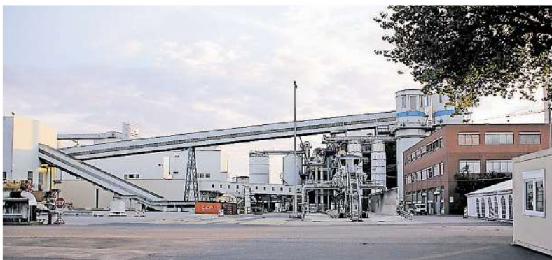
Das Jülicher Werk der Firma Pfeifer & Langen.
